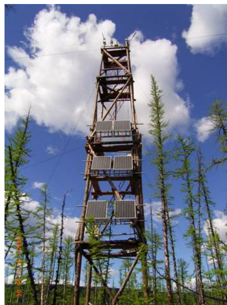
Photo 1.2-8 太陽電池を用いたフラックス観測タワー。(ロシア、ツラ)
