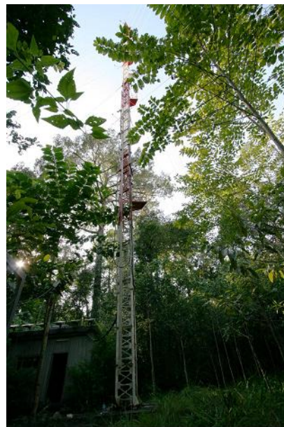
Photo 1.2-3 梯子状の部材を用いて登り降りする「梯子タワー」。(カンボジア国コンポントム州、写真：森林総合研究所清水晃氏提供)
