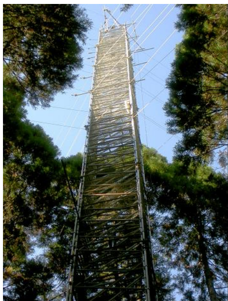
Photo 1.2-2 階段で登り降りする「足場タワー」。(鹿北流域試験地)
