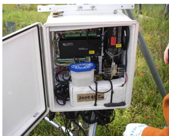
Photo 1.2-13 乾燥剤 (押し入れ用湿気取り) を入れた計測ボックス。
