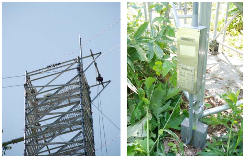
Photo 1.2-9 観測タワーに設置されている避雷針（左図）とアース（右図）。（札幌森林気象試験地）
