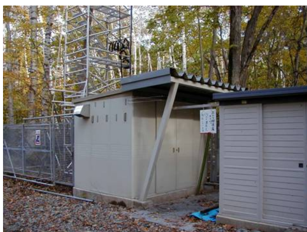
Photo 1.2-12 タワーの直近に建てられた観測小屋 (中央) とボンベ格納庫 (右)。(札幌森林気象試験地)
