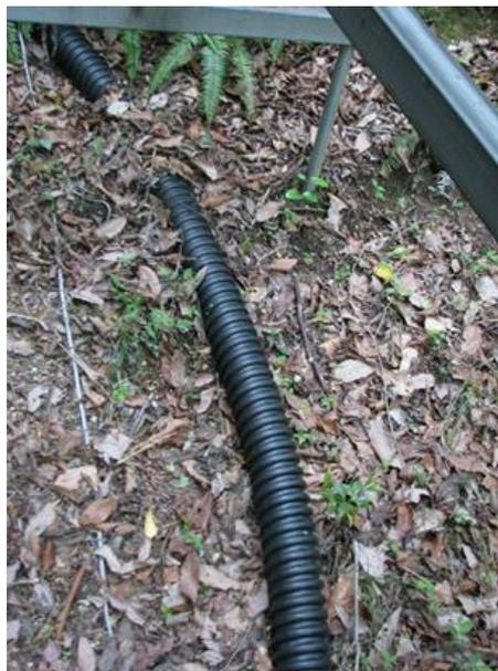
Photo 1.2-7 転がし配線。森林では林床の起伏があるので転がし配線の場合も地中埋設用の蛇腹保護管を用いた方が作業性が高い。(山城水文試験地)
